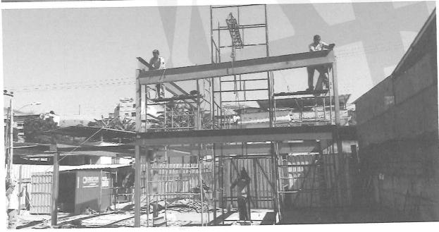
Conforme demonstra as imagens, a Unidade Básica de Saúde - UBS, Padrão Tipo 01, do Bairro Cruzeiro, **não é uma construção no Sistema Construtivo Convencional**, onde é a alvenaria convencional, composta por tijolos cerâmicos que funcionam como divisórias para os ambientes e a parte estrutural da edificação fica por conta de vigas, pilares e lajes de concreto, que criam uma estrutura de sustentação.
